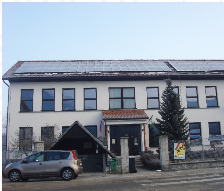
Solarni sistem na šolski stavbi.
