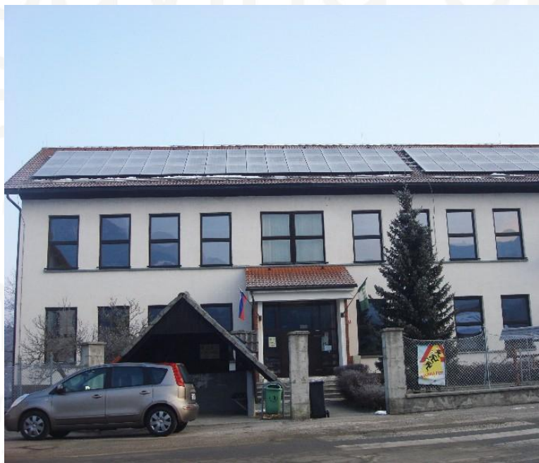
Solární systém na školní budově.
